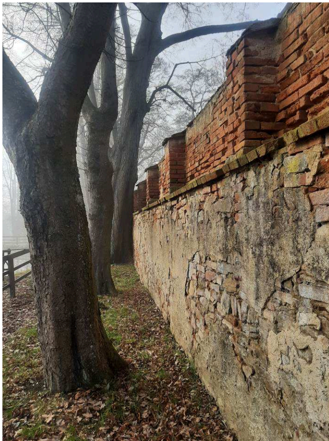
Obr. 6 smíšené zdivo oplocení areálu zámku na západní straně, zdroj: fotoarchiv MěÚ, datum: 17. 01. 2023
